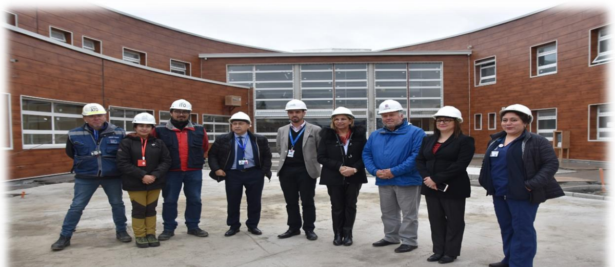
VISTA DEL CESFAM DESDE EL INTERIOR DEL RECINTO. AL MES DE JULIO DE 2019 CONTABA CON UN 86% DE AVANCE. AL AÑO 2020 SE ENCUENTRA EN UTILIZACIÓN.
